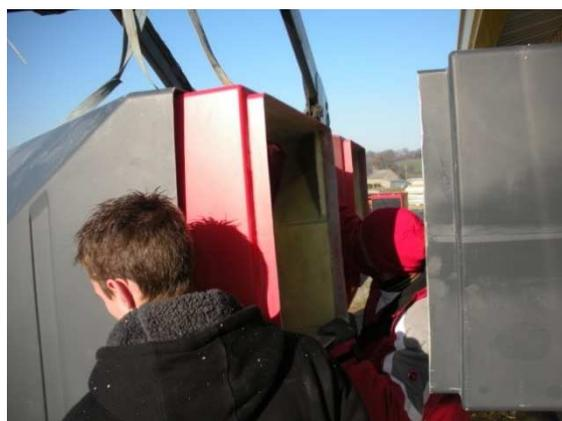
Lorsque les raccords sont bien emboîtés dans le conduit, il faut descendre les pieds et les régler en vérifiant le niveau de l'échangeur. Suivant la pente de la dalle béton, les pieds ne seront pas réglés forcément à la même hauteur.
