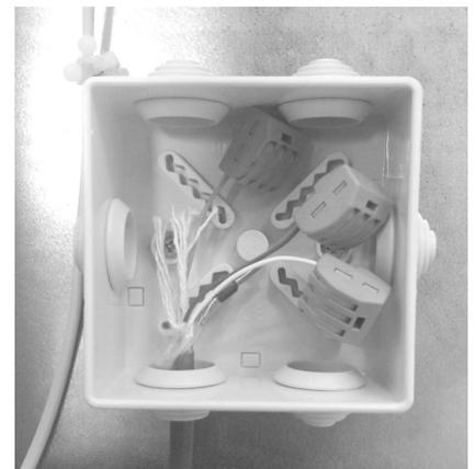
Le boîtier se situe dans le compartiment technique de l'appareil et permet de le raccorder à l'interface INTBUS.
